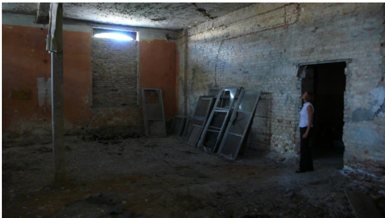
Część nieużytkowana budynku
