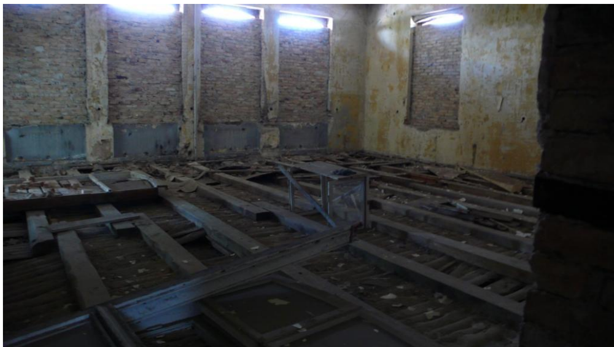
Część nieużytkowana budynku
